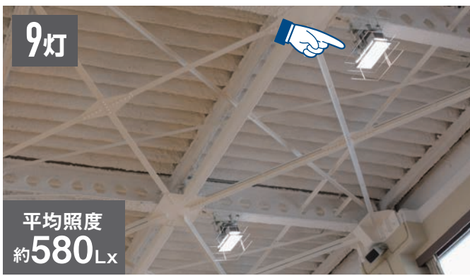
※高天井用LED照明はイメージです。 ※平均照度は床面から1.7mの高さから計測した数値です。
